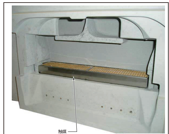
図12 触媒の取り外し
